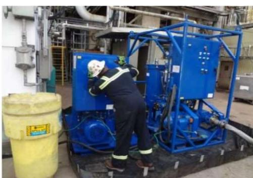
Hidrolik Borularınızın iç temizlikleri önce asit uygulamsa ile sonrasında da komple sistemin yağ ile temizliği NAS 3 seviyesine kadar yerinize servis ekibimiz ile yapılmaktadır.
